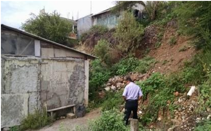
TALUD INESTABLE DE 6 METROS.
