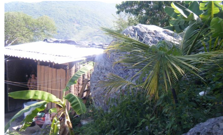
VISTA DE UNA DE LAS VIVIENDAS QUE REQUIERE DEMILICION DE ROCA PARA DISMINUIR EL RIESGO EN LA VIVIENDA
