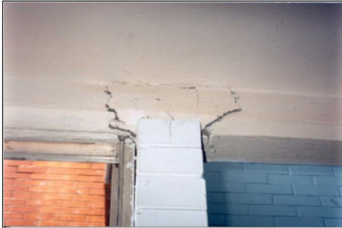
***Figura 2.70 Grietas en la unión del castillo-dala en un Kinder debido a los asentamientos diferenciales***
