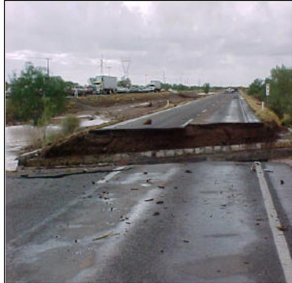
**Figura 2.19** Tramo Obregón – Guaymas. Puente dañado que presentó 3 claros de 7 m c/u, de los cuales uno quedó en pie y tuvo que ser demolido por seguridad
