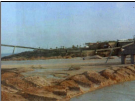
**Figura 2.43** Puente “Los Tules” ubicado en el Km 15 + 250 del tramo Cabo San Lucas – La Paz en el que se observa la destrucción de los terraplenes de acceso
