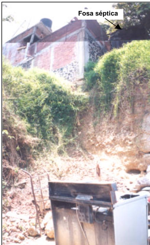
**Figura 2.62** Cortes verticales sin protección alguna
