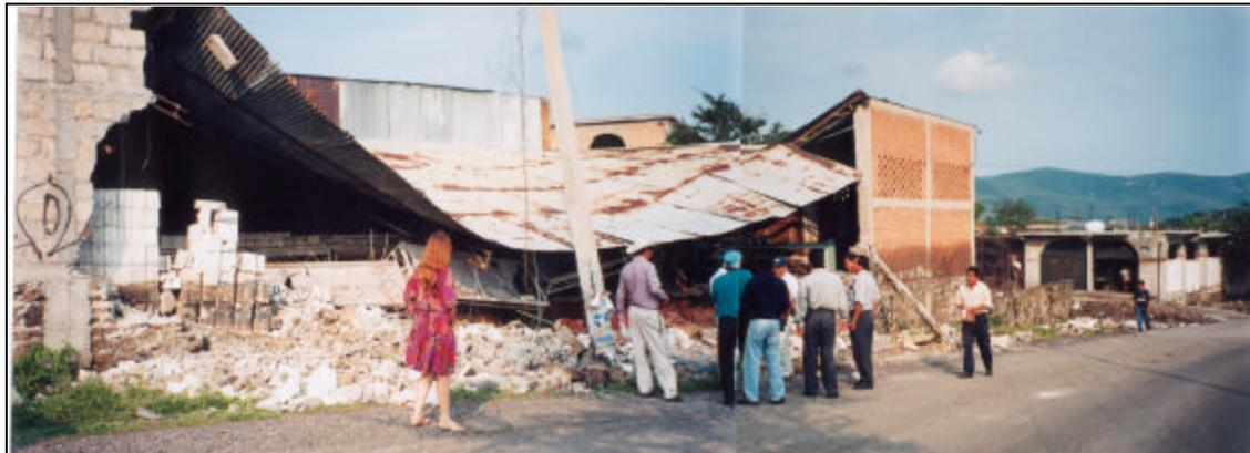
**Figura 2.72 Pared derribada de una fábrica de cerámica, por la acción del agua que penetró a ésta, colonia Las Cumbres, municipio de Emiliano Zapata**
