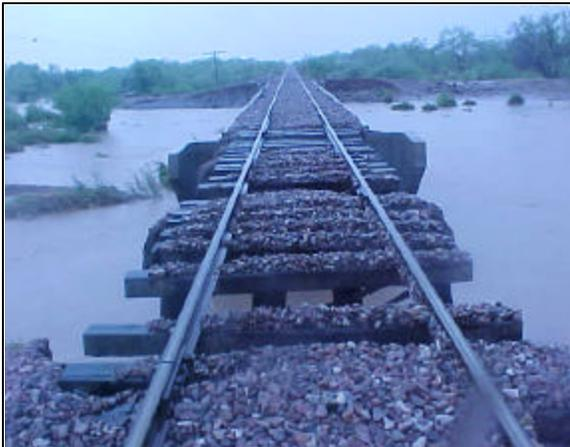
**Figura 2.20** Daños ocasionados por las lluvias torrenciales, generadas por Juliette, en la infraestructura de transporte
