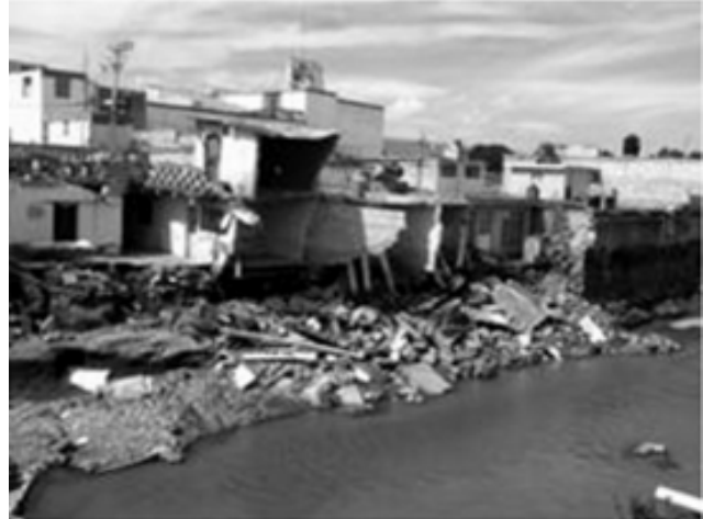
Viviendas afectadas en el municipio de Tulancingo.
