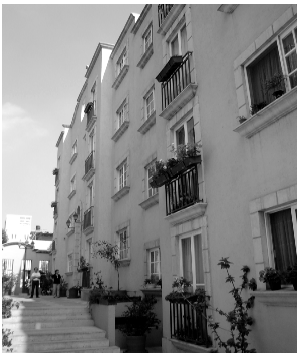
Vista del inmueble ubicado en la calle Morelia No. 78
