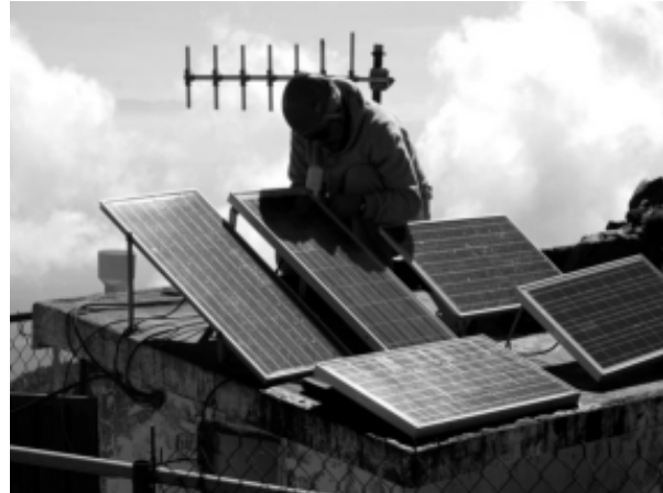
Modernización de enlaces y equipos en la estación CANARIO
