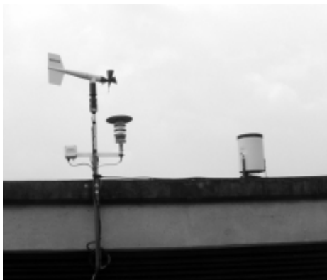
Montaje de los nuevos sensores meteorológicos en las instalaciones del CENAPRED
