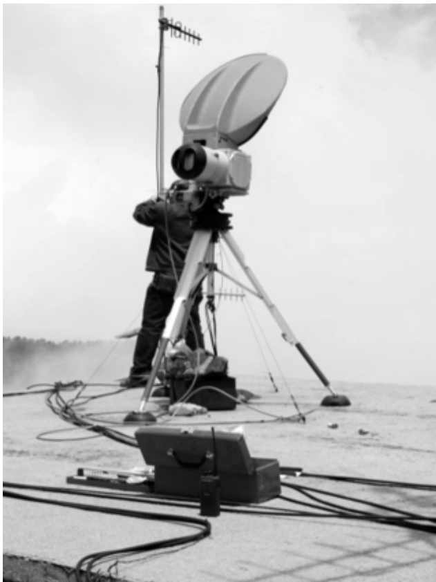
Reforzamiento de enlaces de comunicación, Altzomoni
