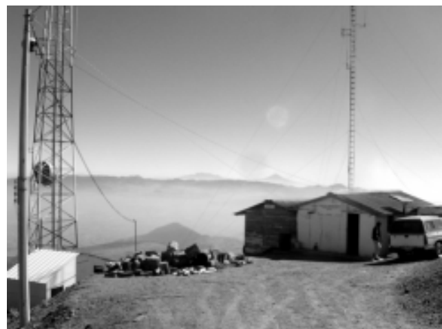
Vista desde la estación
