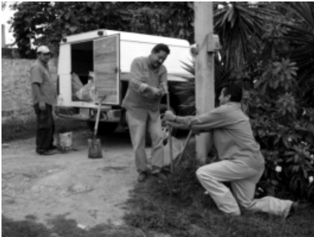
Instalación de puntos de medición para deformación en la ladera "La Aurora", Teziutlán, Puebla
